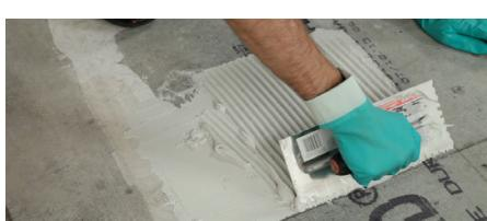
Étalez ensuite le mortier avec le côté dentelé de la truelle en vous assurant que le mortier est réparti uniformément, dans une seule direction et sans tourbillon.
