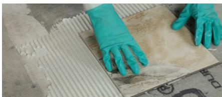
Testez le mortier en appuyant fermement sur un carreau dans le mortier. Remuez-le légèrement afin de couvrir les bords.
