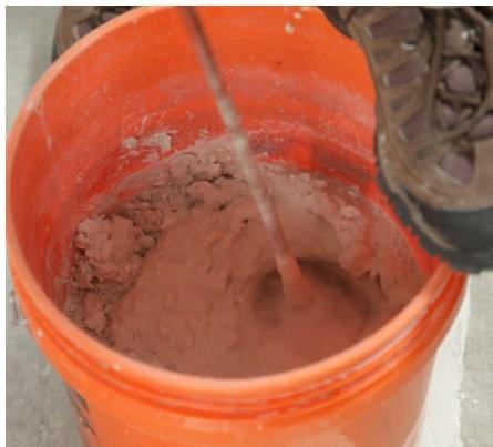
Mélangez le mortier approprié pour vos carreaux conformément aux directives figurant sur le sac. Le mortier est corrosif, assurez-vous de porter un équipement de protection. Une fois sec, le mortier est inutilisable, évitez donc d'en préparer trop.
