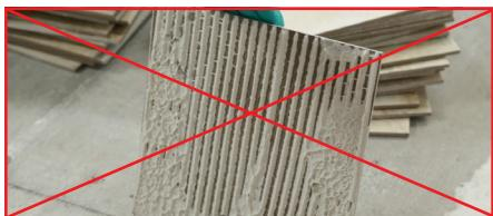
Soulevez ensuite le carreau afin de vérifier que l'envers est totalement couvert de mortier. Si ce n'est pas le cas, assurez-vous d'avoir respecté les étapes du test, utilisé suffisamment de mortier, mélangé correctement le mortier et vérifiez qu'il n'a pas commencé à sécher.
